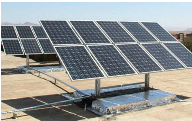
سازه سقف خانه
