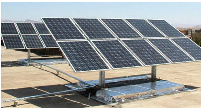
سازه سقف خانه
