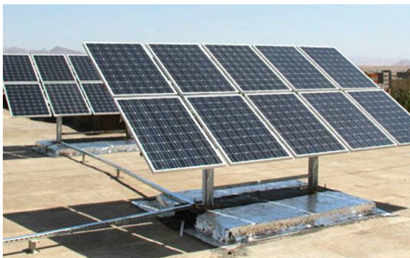
سازه سقف خانه
