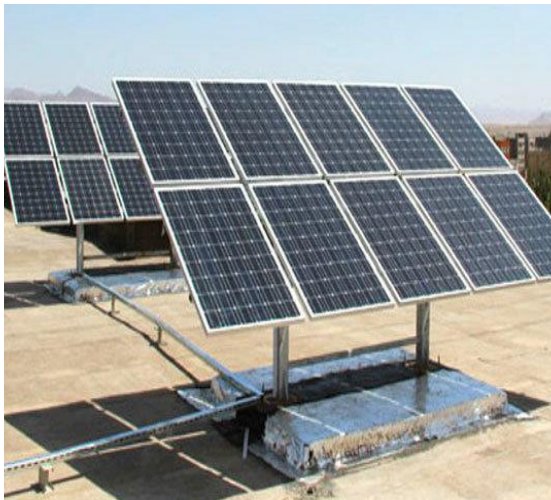
سازه سقف خانه
